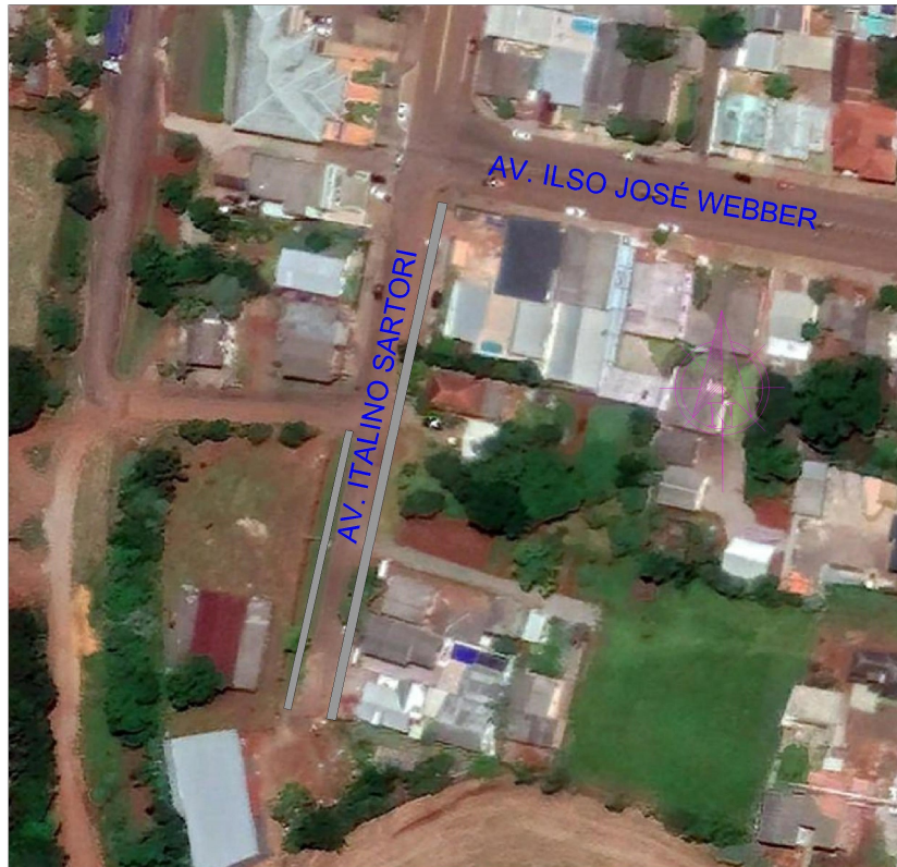
Figura 2: Trecho da Avenida Italino Sartori a receber a pavimentação asfáltica.
