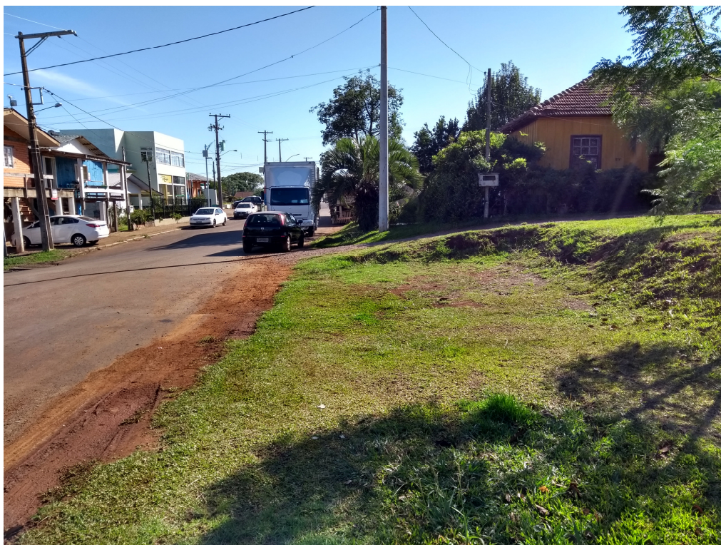
Figura 2: Faixa lateral ao pavimento na Av. Italo Sartori onde será removido material para a posterior execução de sub-base e de base.
