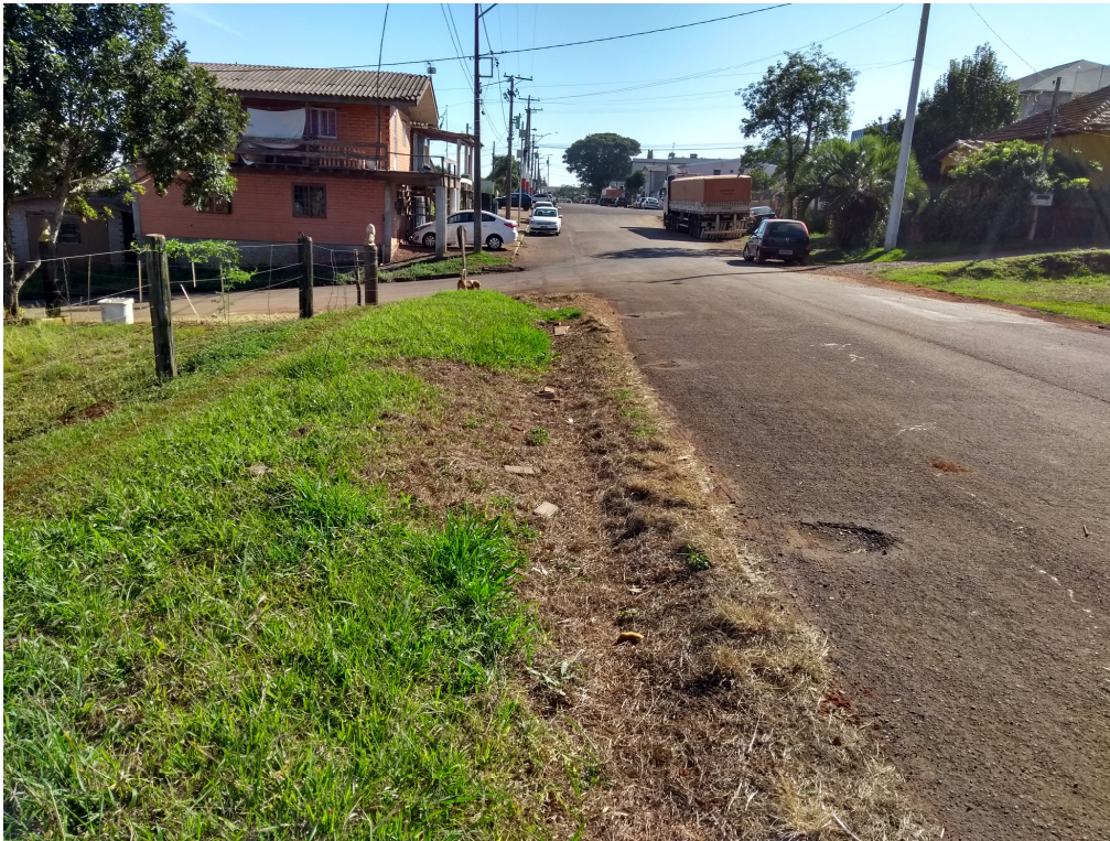
Figura 3: Faixa lateral ao pavimento na Av. Italo Sartori onde será removido material para a posterior execução de sub-base e de base.
