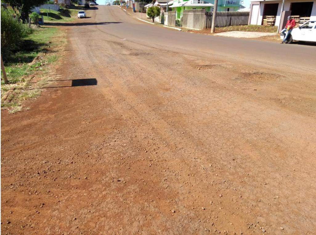
Faixa lateral ao pavimento na Av. Fioravante Franciosionde onde será removido material para a posterior execução de sub-base e de base.
