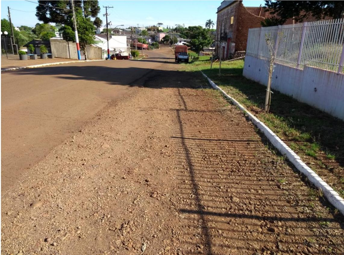
Faixa lateral ao pavimento na Av. Fioravante Franciosi onde será removido material para a posterior execução de sub-base e de base.
