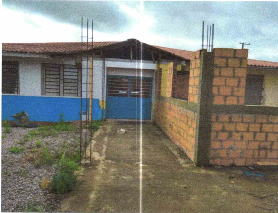
Pilares a serem concretados
