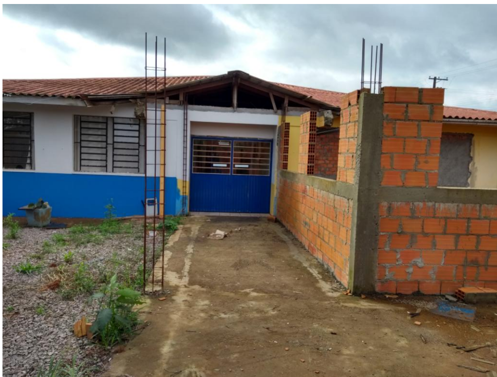
Pilares a serem concretados
