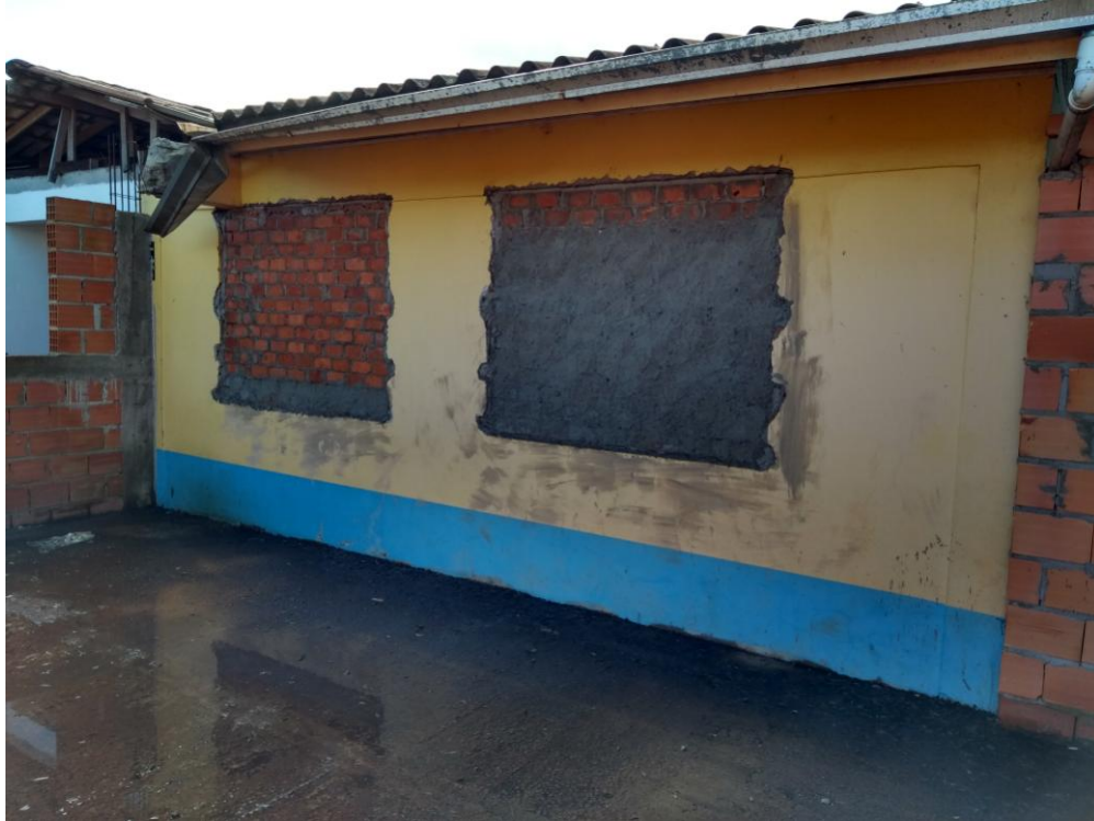
Parede a ser executada encostada na parede da edificação existente
