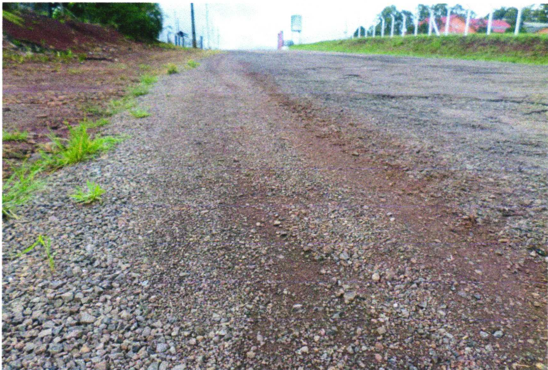
Figura 2: Trecho em que a pista de rolamento será alargada.
