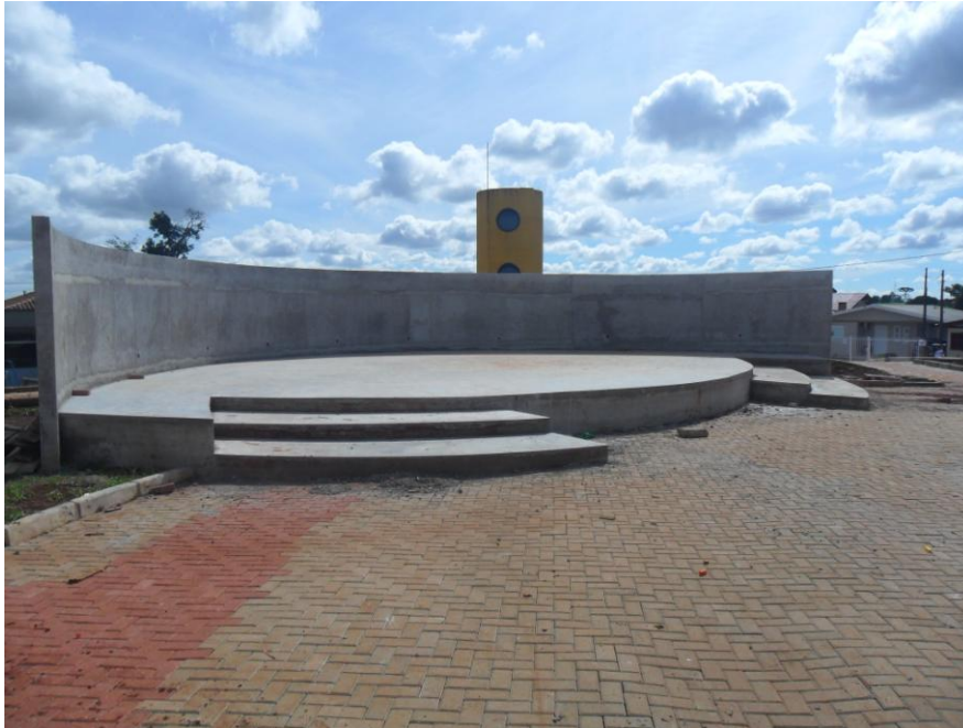
Palco existente a receber revestimento em pedra basalto.
