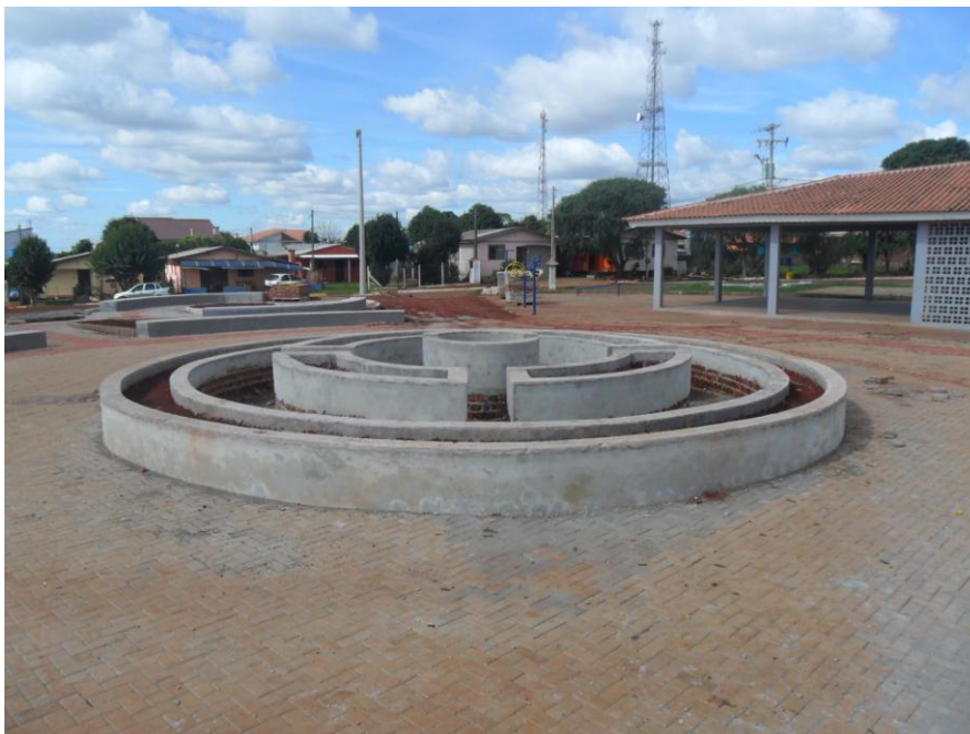
Canteiro existente a receber revestimento em pedra basalto
