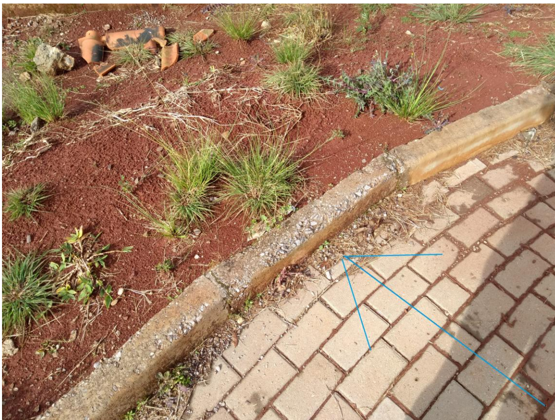
Exemplo de meio-fio a ser substituído
